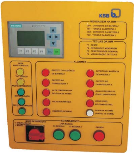
Painel de partida automática conforme NFPA 20 para conjuntos de combate à incêndio com motores a diesel.
